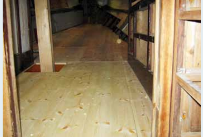
Dørken tar form i skipperlugar og ruff, og ja, det mangler et skott på bildet!
